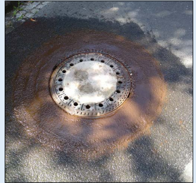
Schachtrahmenregulierung
