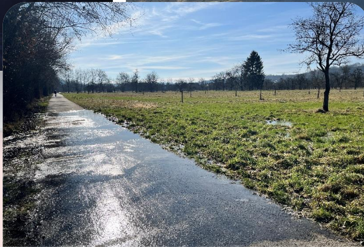
Sanierung der Drainagen am Radweg
