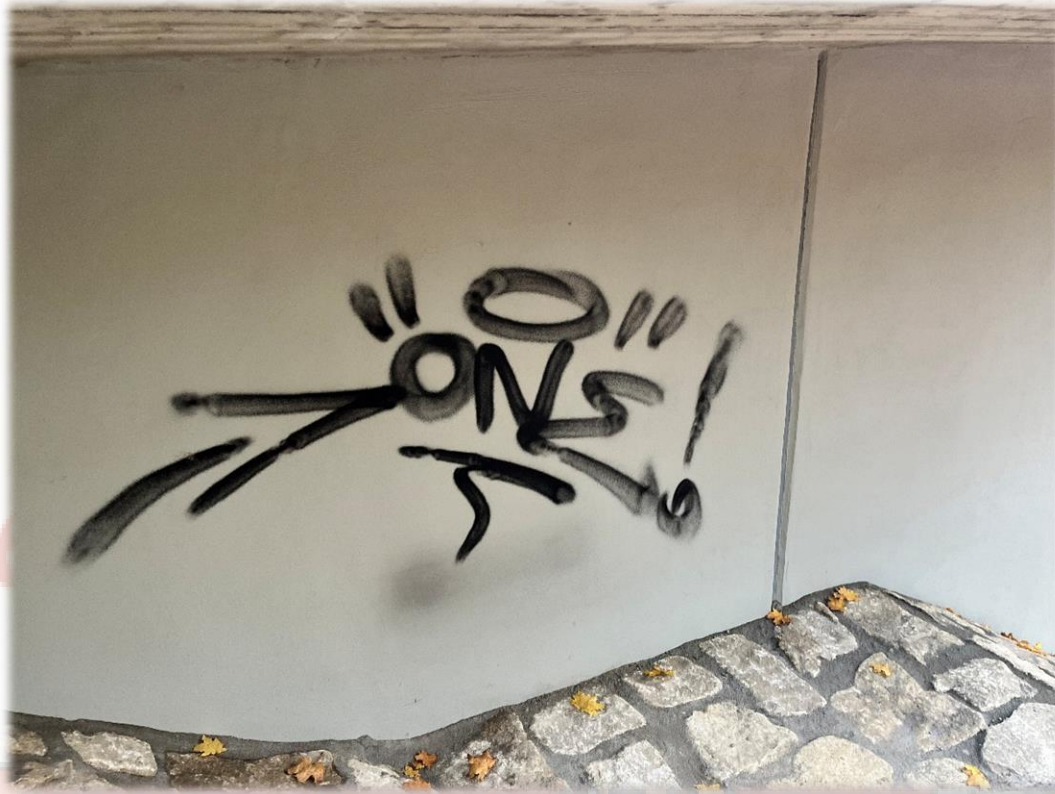
Foto der neu sanierten Brücke über die Staatsstraße noch vor der offiziellen Wiedereröffnung
