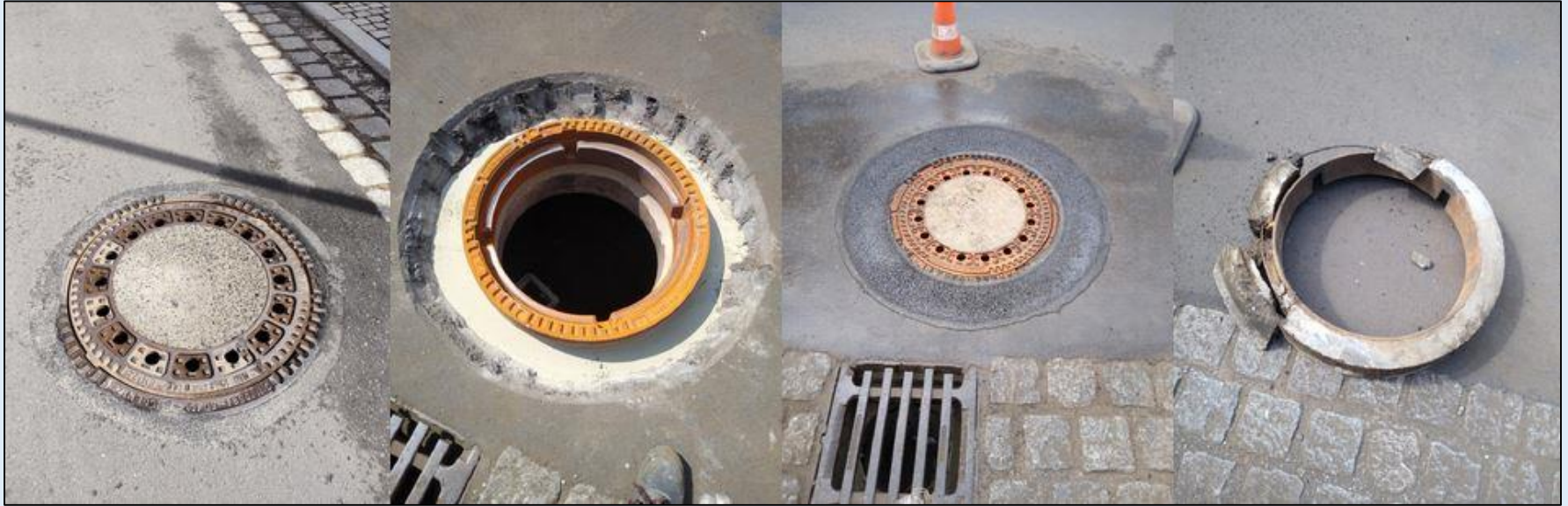
Schachtrahmenregulierung
